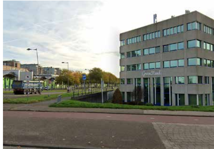
Deel waterkering uitgevoerd met keerwand ter hoogte van kruising Olympiaweg & Stadionweg
