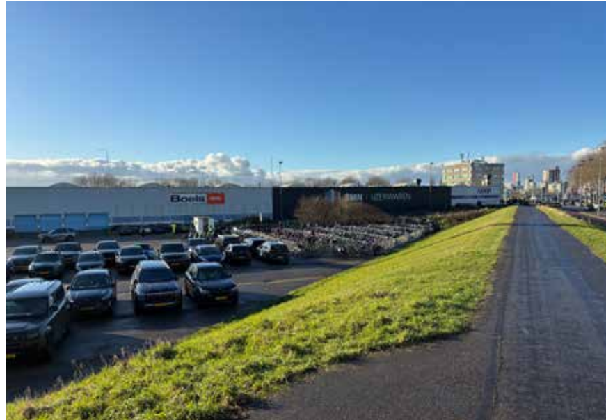
Waterkering met zicht op de lager liggende Stadiondriehoek (volledig uitgevoerd als talud)
